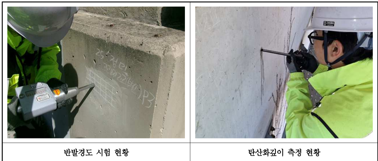
【사진 6.4.1】 콘크리트 내구성조사 현황
