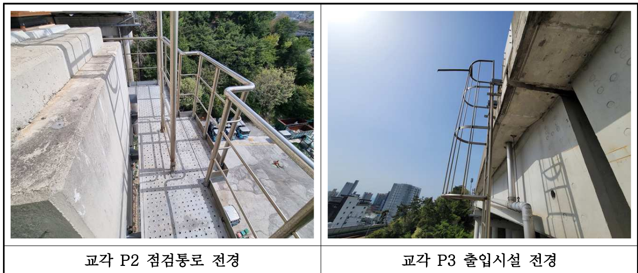
【사진 6.3.26】 교량 점검시설 전경
