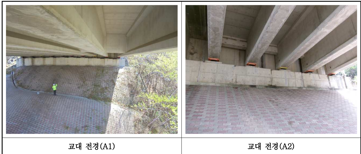
【사진 6.3.8】 교대 전경
