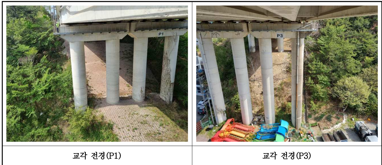
【사진 6.3.10】 교각 전경
