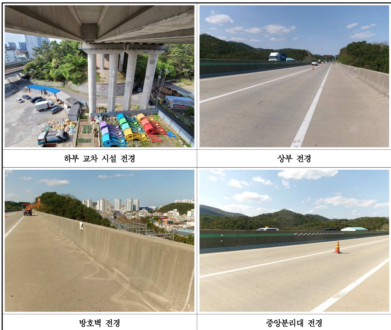
【사진 6.2.1】 주변환경 및 하중변화 전경
