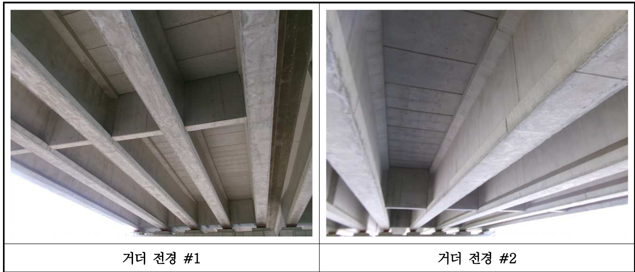
【사진 6.3.4】 거더 전경
