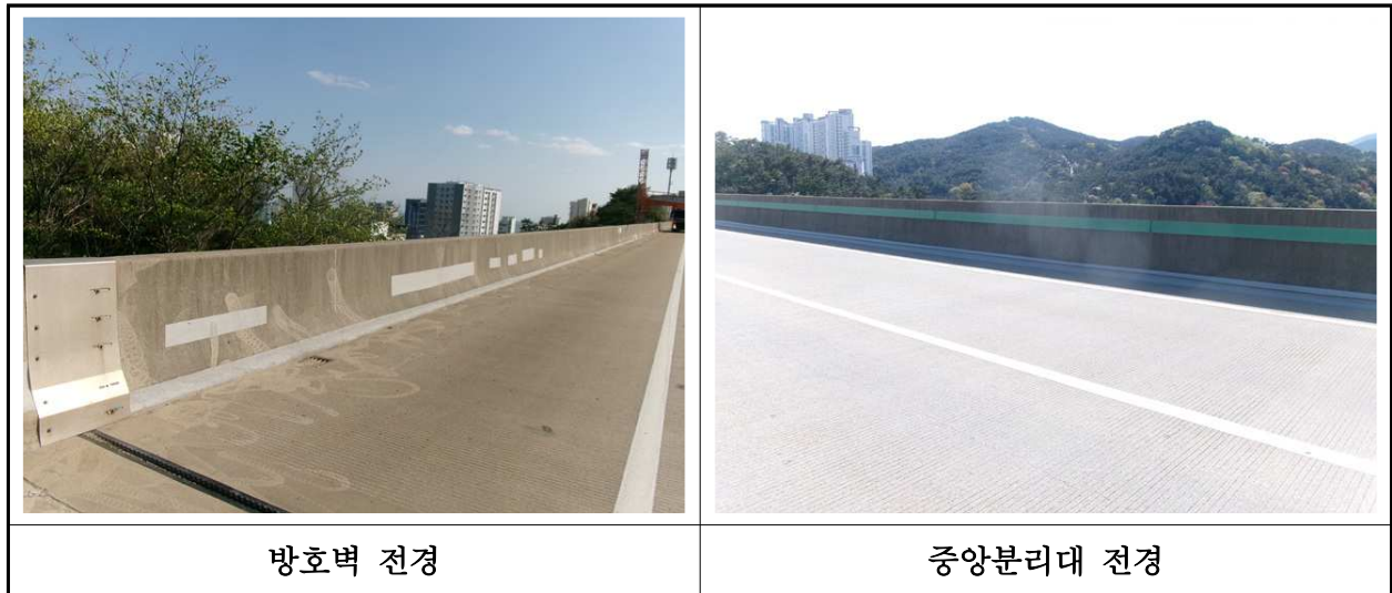
【사진 6.3.24】 방호벽 및 중분대 전경
